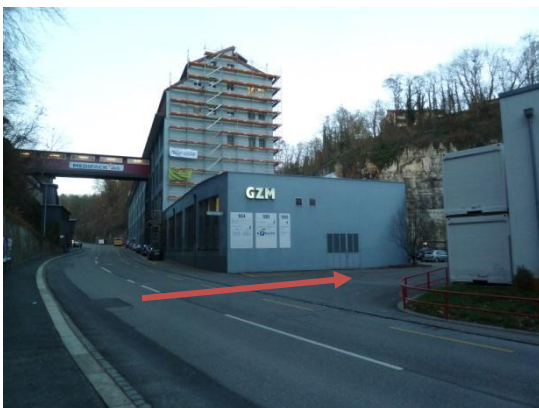
1) Einfahrt unterhalb der Mühlentalstrasse 184
