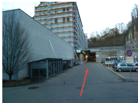
2) Vorfahrt an der Rückseite des Gebäudes bis zur Rampe Ost
